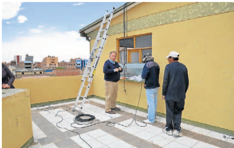
El empresario, con dos operarios durante la instalación. :: EL NORTE
